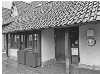
Standort Feuerwehr, Hauptstr.3
